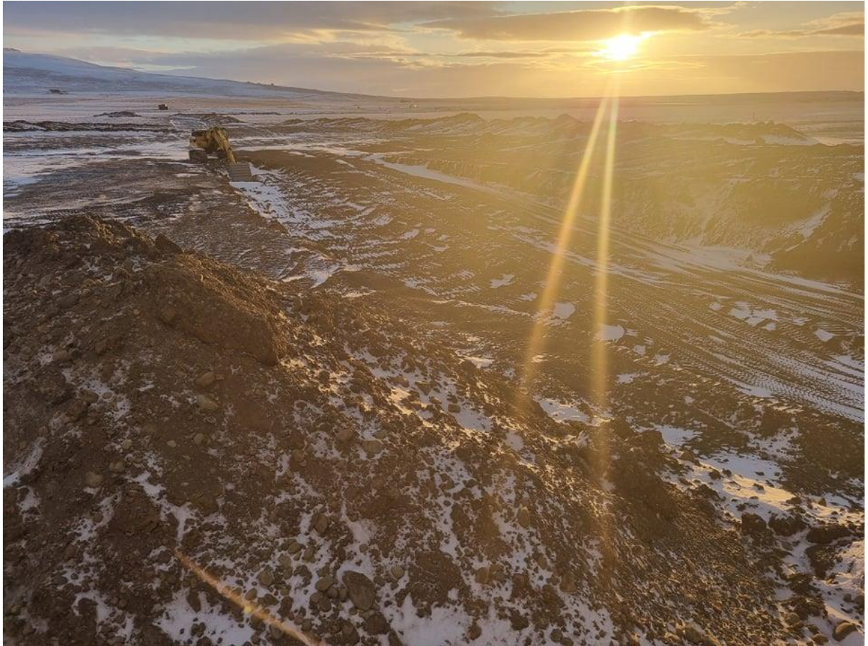
Mynd 1. Framkvæmdir við nýjan Þverárfjallsveg hafnar í janúar 2022. Framkvæmdin var sameiginleg áhersla sveitarfélaga á Norðurlandi vestra í Samgöngu- og innviðaaáætlun landshlutans frá árinu 2019. Mynd, Guðmundur Haukur Jakobsson.
