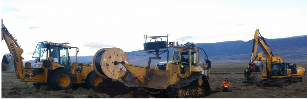
Mynd 18. Frá lagningu ljósleiðara í Skagafirði. Mynd Skagafjörður
