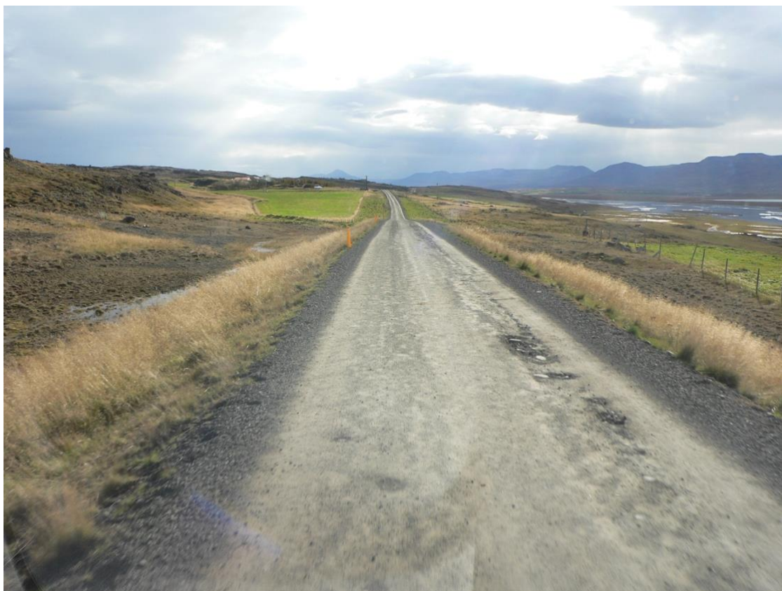
Mynd 4. Hegranesvegur (764) í Skagafirði. Mynd, Ólafur Guðmundsson.
