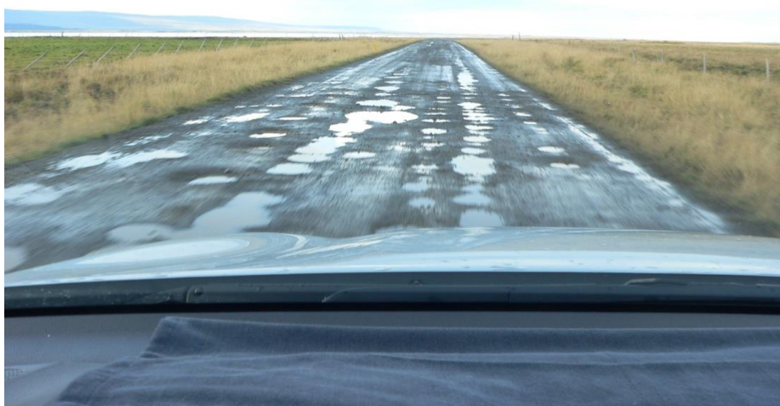
Mynd 13. Þingeyravegur. Fjölfarinn ferðamannavegur í Húnavatnshreppi. Mynd, Ólafur Guðmundsson.
