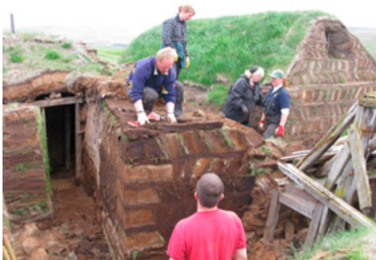
Námskeið í torfhleðslu og grindarsmíði á vegum Fornverkaskólans.
